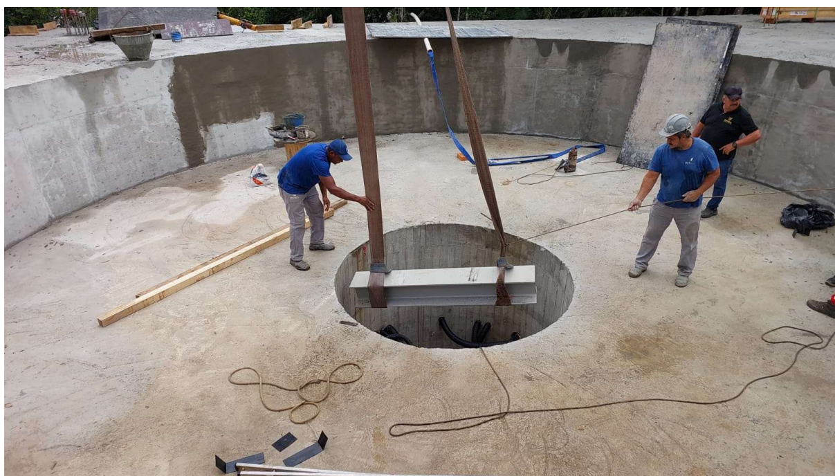
Figura 11 - Construção da base de sustentação da torre
