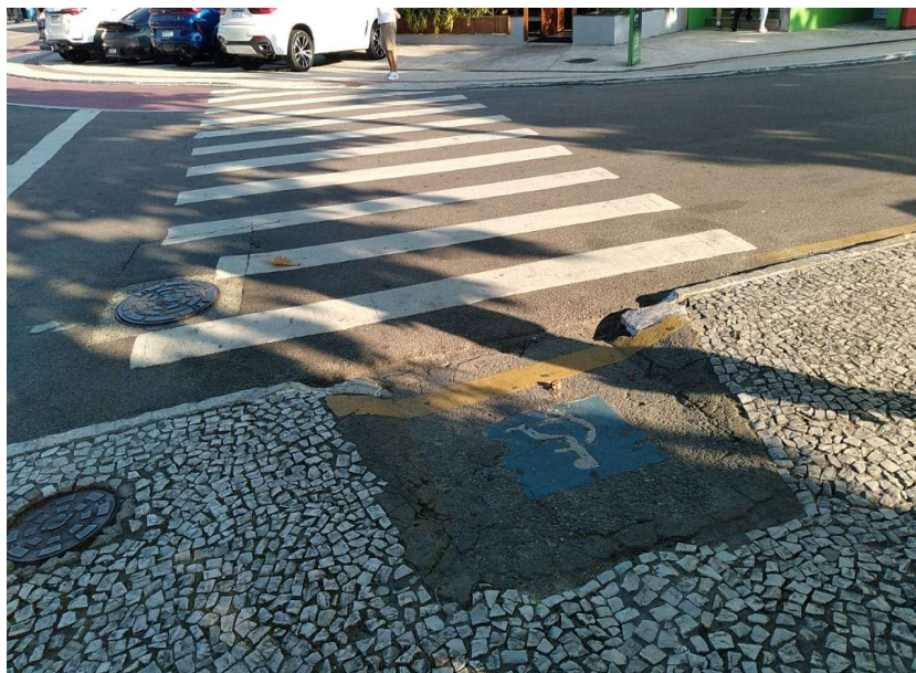
Figura 143 - Calçada com rampa de acessibilidade em condições inadequadas, existente no início da Avenida Atlântica, do lado oposto da estação barra sul.
