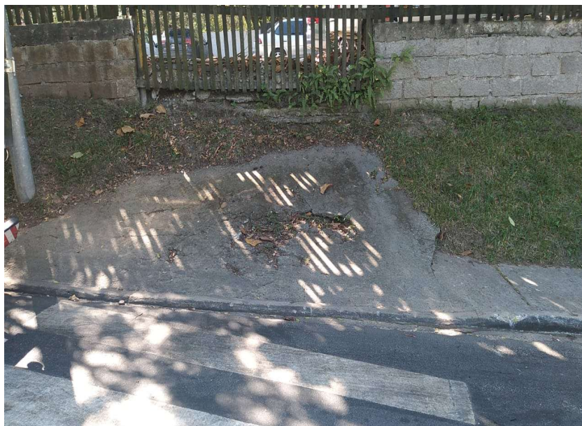
Figura 156 - Calçada em condições inadequadas e sem rampa de acessibilidade, existente na Avenida Rodesindo Pavan, do lado oposto ao acesso da estação laranjeiras.
