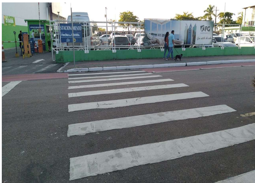
Figura 136 - Faixa de travessia de pedestres sem rampa de acessibilidade, existente na Avenida Normando Tedesco, ao lado do acesso do estacionamento da estação barra sul.
