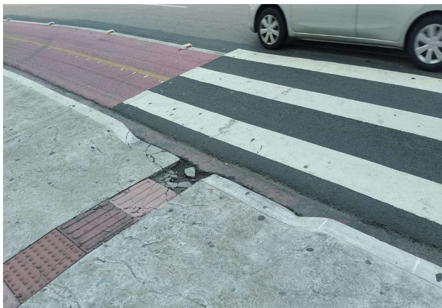
Figura 138 - Calçada com rampa de acessibilidade em condições inadequadas, existente na Avenida Normando Tedesco, do lado da estação barra sul.
