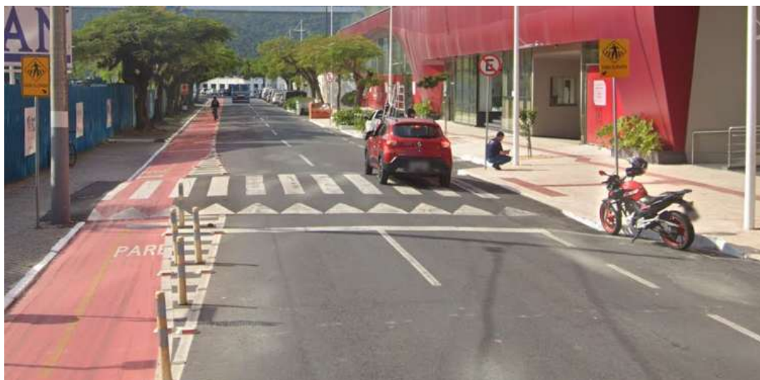
Figura 192 - Faixa Elevada de Travessia de Pedestres na Avenida Normando Tedesco. Fonte – Autor, 2025.
