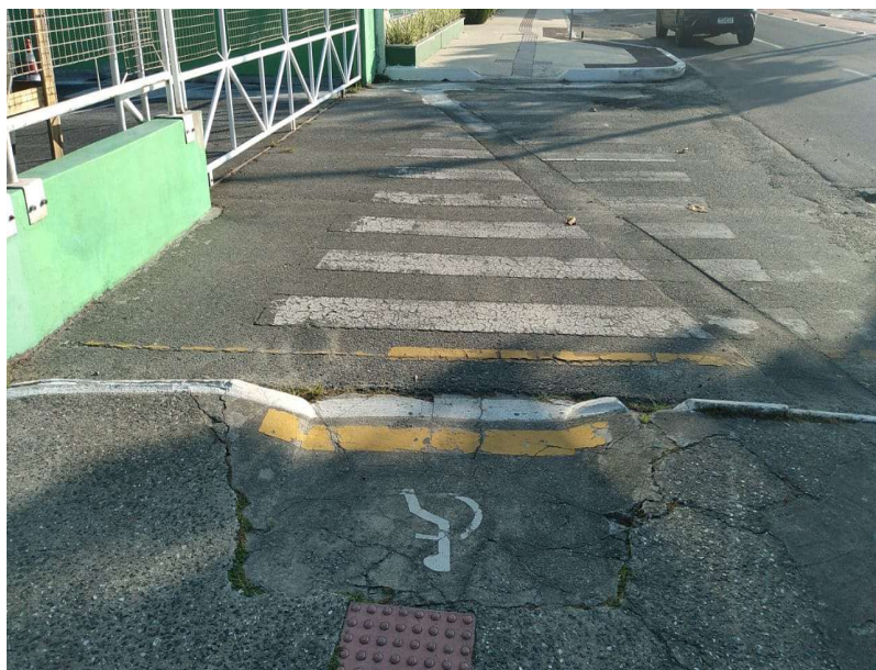
Figura 146 - Faixa de pedestres com sinalização desgastada e rampa de acessibilidade em condições inadequadas, existente na Avenida Atlântica, aos fundos do estacionamento da estação barra sul.
