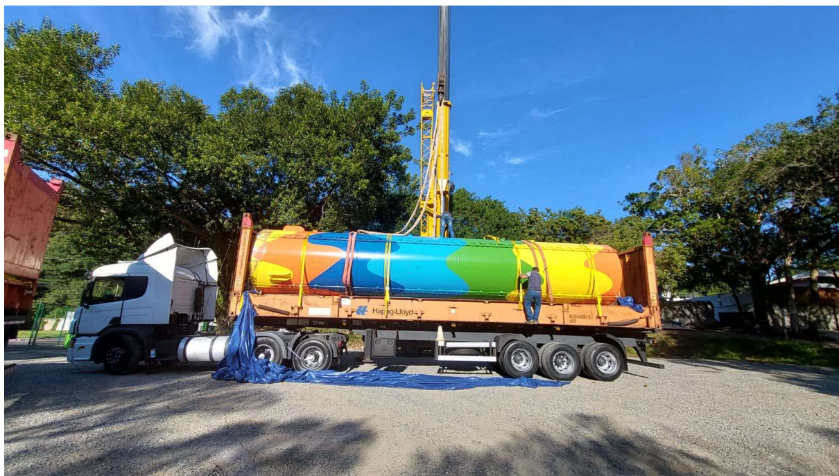
Figura 12 - Transporte dos módulos da torre
